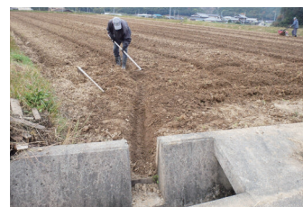
排水溝と落水口の連結
