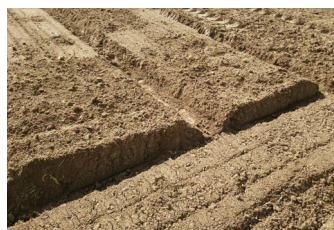
排水溝の設置と連結
