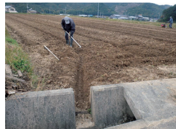
排水溝と落水口の連結
