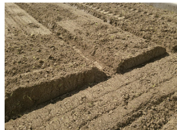
排水溝の設置と連結
