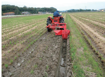
播種前の排水溝設置
