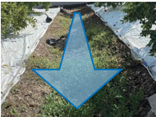
写真6 傾斜に沿って雨水等が流出する作業道
