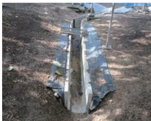
写真6 排水路の整備
